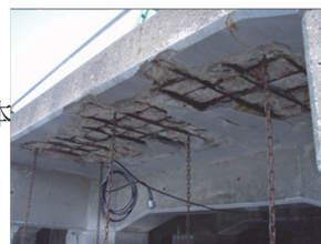
図1 鉄筋腐食
