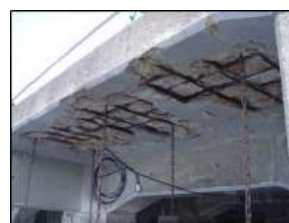
図1 鉄筋腐食
