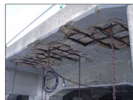
図1 鉄筋腐食
