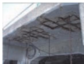
図1 鉄筋腐食
