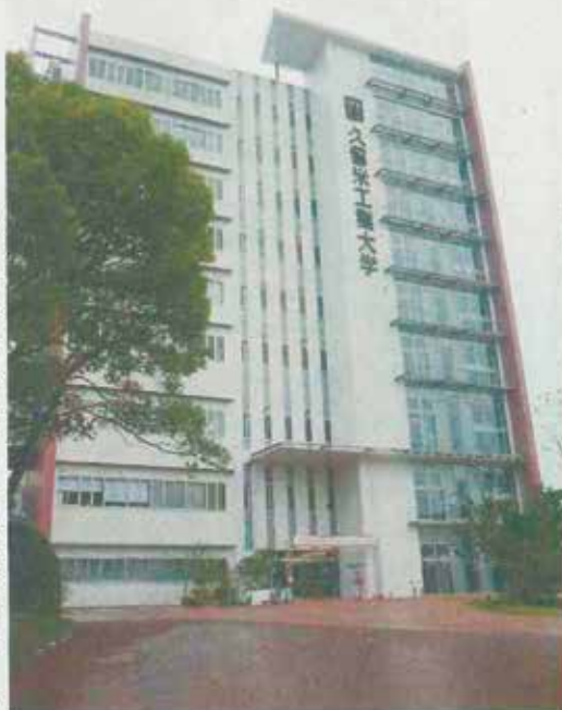
完成した100号館
