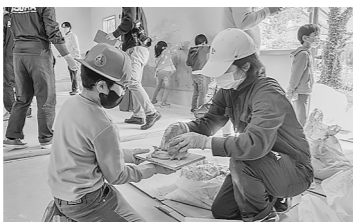
〔川の駅でのタイル張りの様子〕
