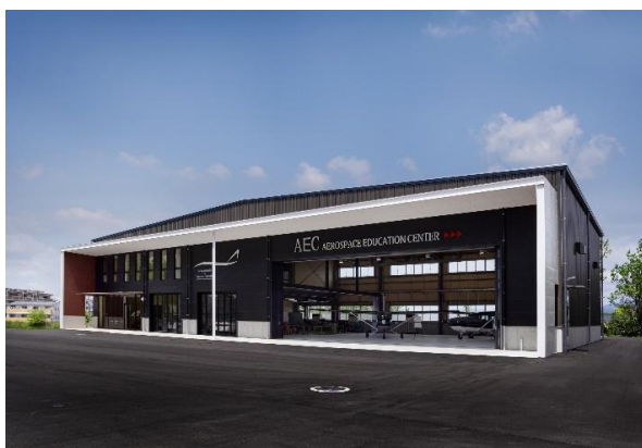
航空宇宙実習棟(AEC)全景
