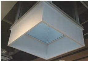
太陽が出ていて外が明るいのに、室内で照明をつけているのは非常にもったいない話です。そこで、外の太陽光を取り入れて室内に導き、照明エネルギーを削減するための一つの省エネ技術として、光ダクト技術があります。本研究では光ダクトの素材として従来の鏡面金属板ではなく、段ボールダクト素材を使用し、安価な簡易型光ダクトを提供しています。
