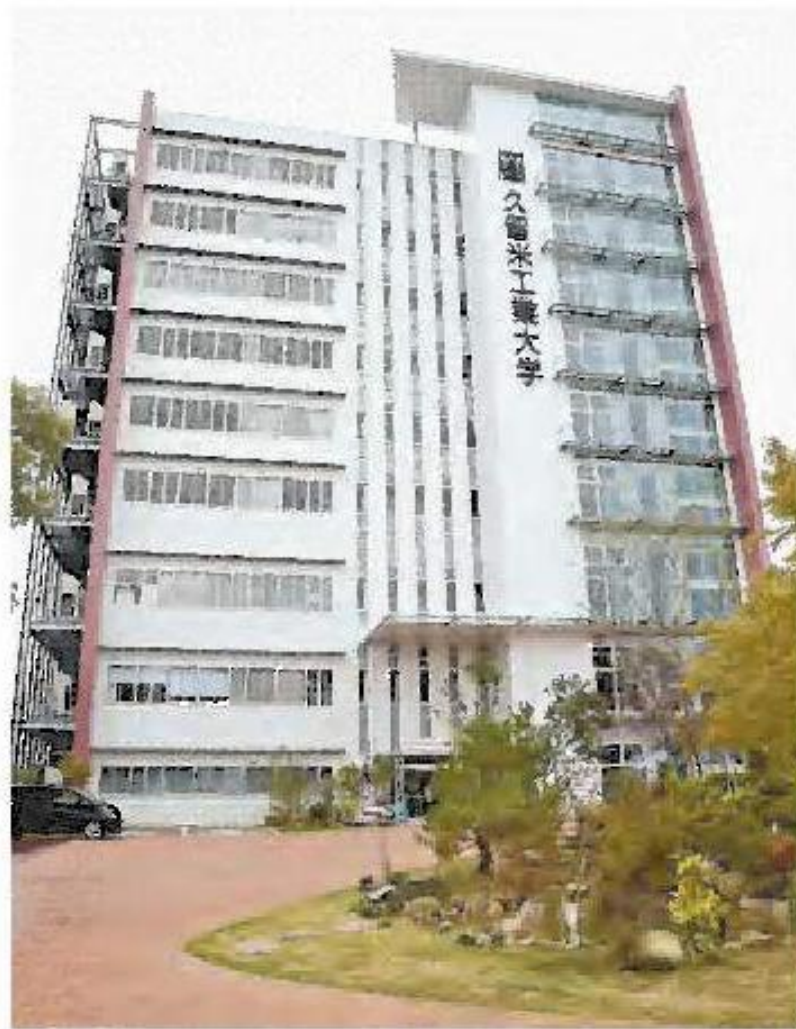
完成した100号館
