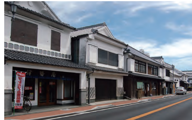
電線の地中埋設が実施された吉井の町並み
