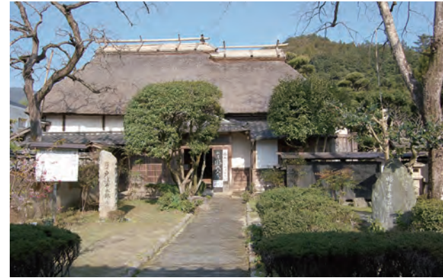
茅葺き屋根の武家屋敷が残る秋月の旧戸波家
