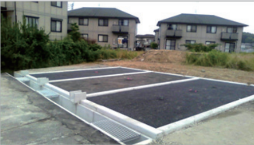
水貯留地盤の試験ヤードの外観
